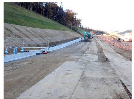
付替河川 (施工中)
